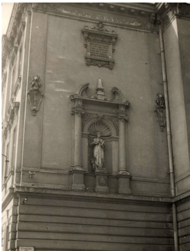
Obr. 17, 18: Postup degradace výzdoby severního průčelí, 60. léta a 80. léta (archiv Městského muzea v DKnL, Geislerova sbírka, Gymnázium, 172/99; Gymnázium, F3/91, F1626/7 Městské muzeum DKnL).
