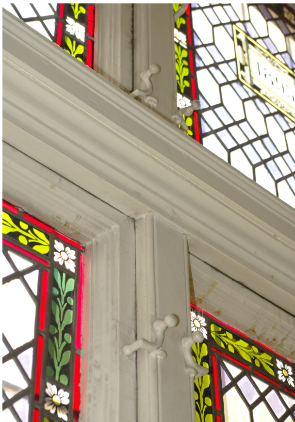
Obr. 70, 71: Detaily profilací původního vitrajového okna (Kudrnovský, 2013).
