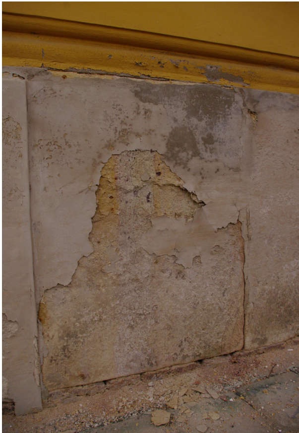
Obr. 74, 75: Pohled na degradovaný pískovcový sokl jihovýchodního nároží východního křídla budovy; detailní záběr na degradovaný pískovcový sokl téhož nároží s výkvěty solí (Kudrnovský, 2013).
