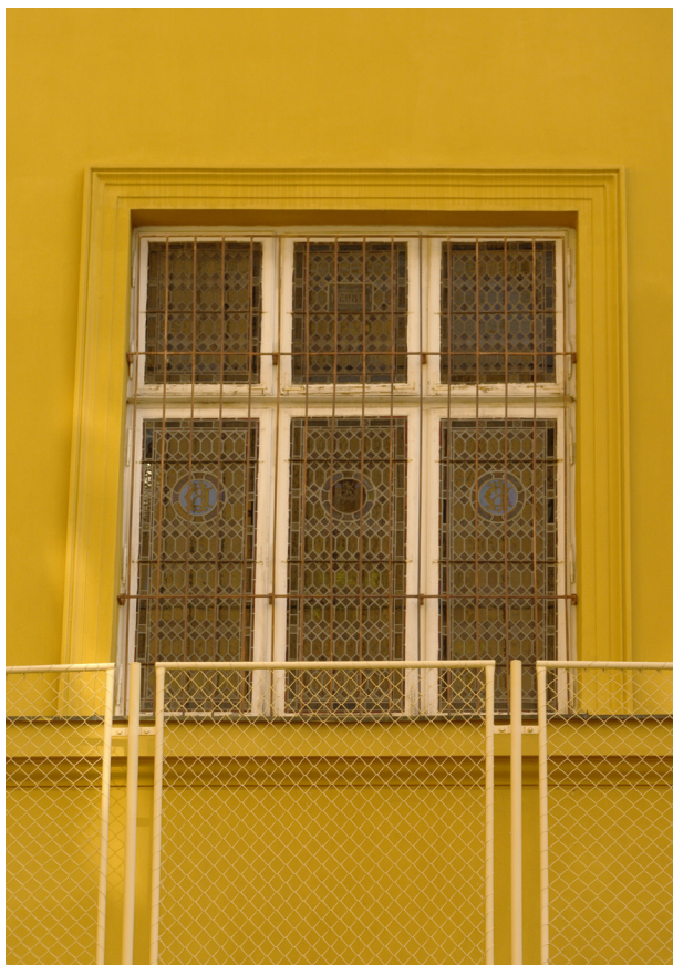
Obr. 68, 69: Původní zdobné šestikřídlé vitrajové okno osvětlující prostor schodiště (Kudrnovský, 2013).
